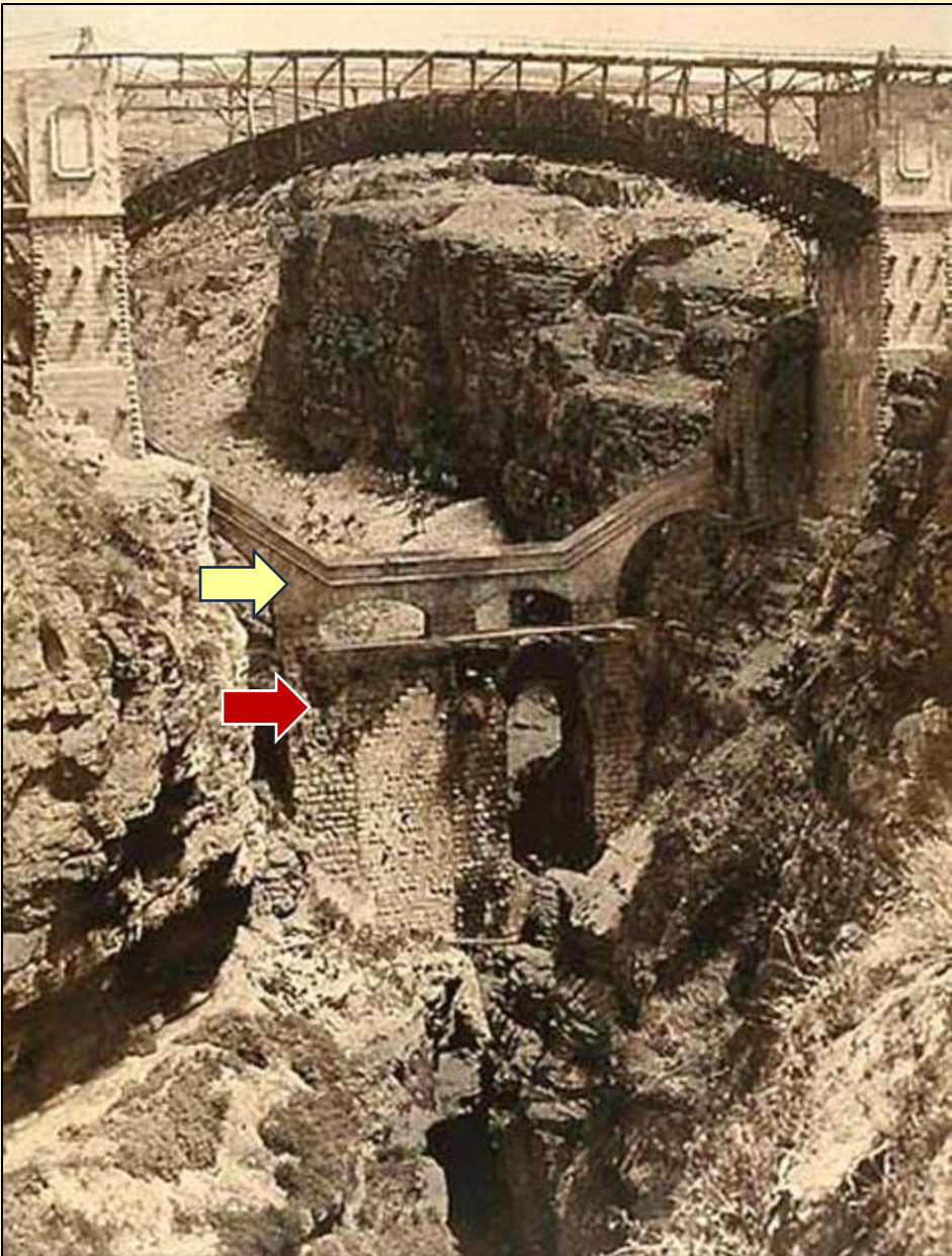
Flèche jaune : L'ancien pont EL KANTARA achevé sous Salah Bey qui remplace l'ancien pont romain (flèche rouge) Au dessus un nouveau pont est en construction
