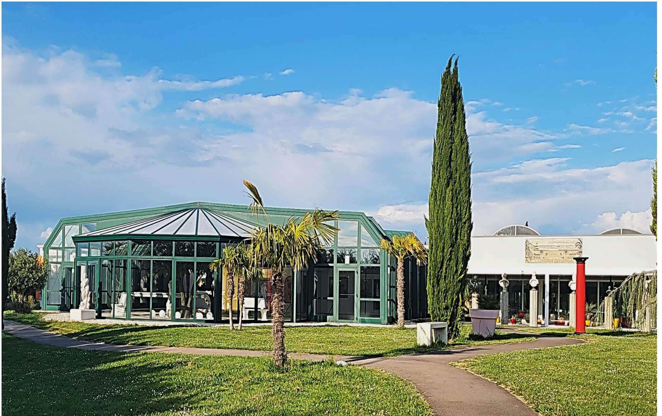
INSTITUT ASCLEPIADE : Les installations de balnéothérapie (à gauche, l'ODYSSEE ; à droite la piscine médicale) 68
